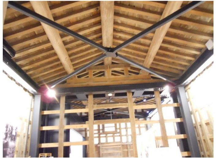
一俵60kgの米俵が6000俵保管されていた米蔵。写真ではわかりづらいですが、黒い鉄筋と側壁との間隔が地面と天井では微妙に・・・
